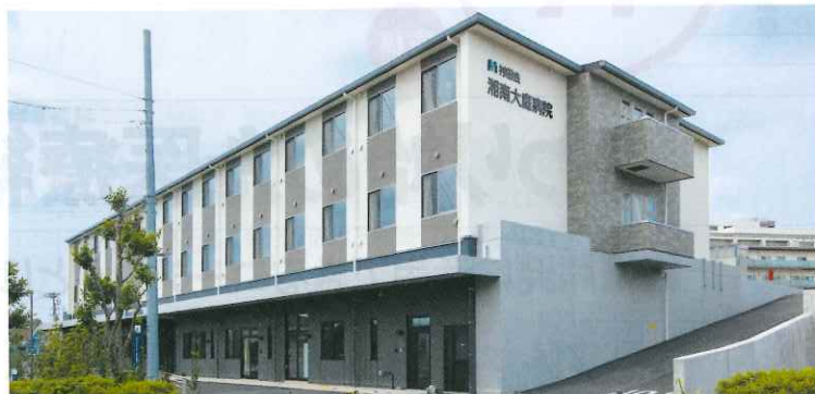
〔写真2〕「医療法人社団村田会『村田会湘南大庭病院』」1階は鉄筋コンクリート造、2、3階病棟は木造とし、木造枠組壁工法を採用した
